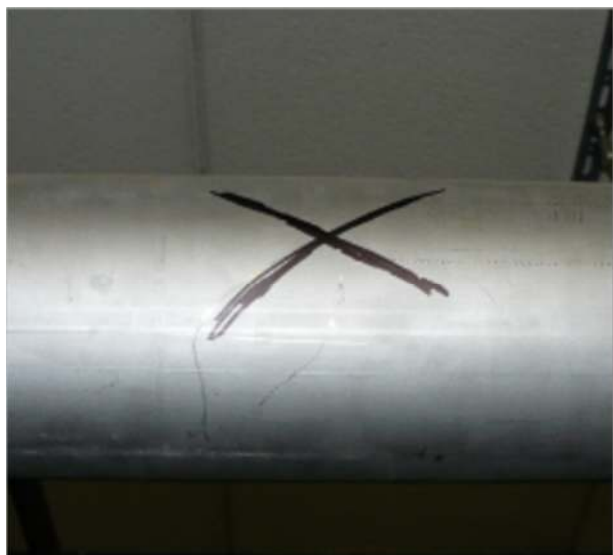
Slika 1: Označimo mesto, kjer bomo namestili priključek
